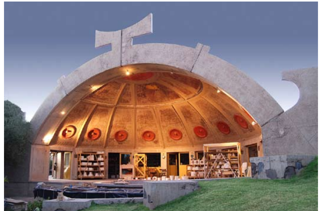
Arcosanti, Arizona, EE. UU.
