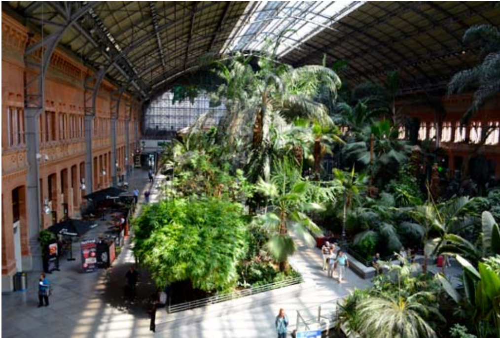
Estación de Atocha, Madrid, Espanha
