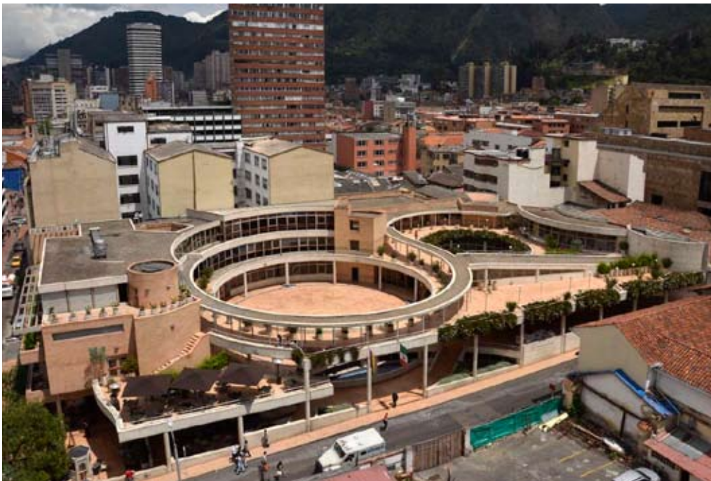
Vista Geral do Edifício
